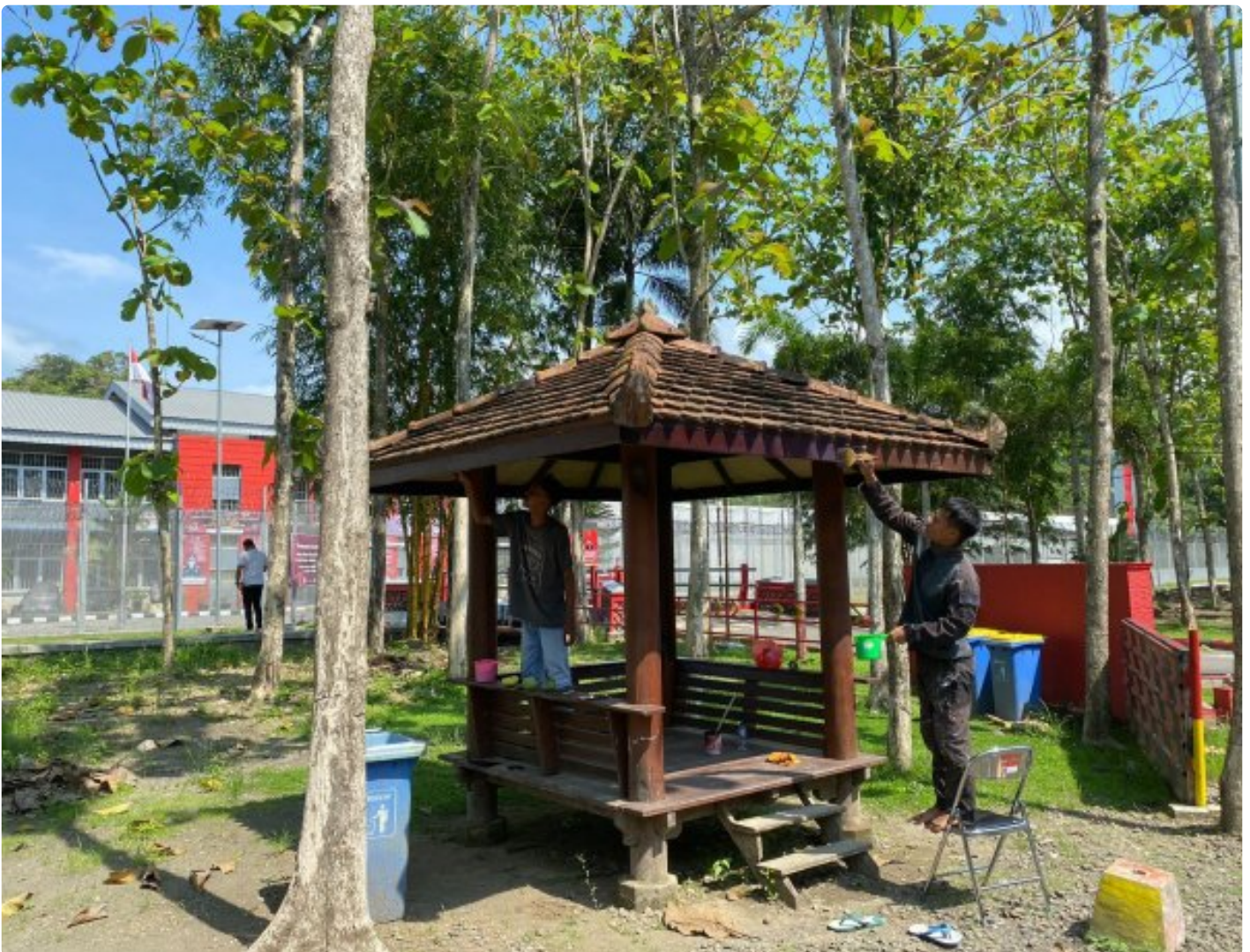
Pengecatan Pos Pengamanan, Dalam Rangka Perawatan Sarpras Lapas Pasir Putih Nusakambangan
