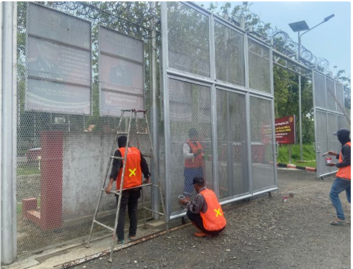
Pengecatan bangunan dan pagar Lapas Pasir Putih dalam rangka sambut HBO ke-59
